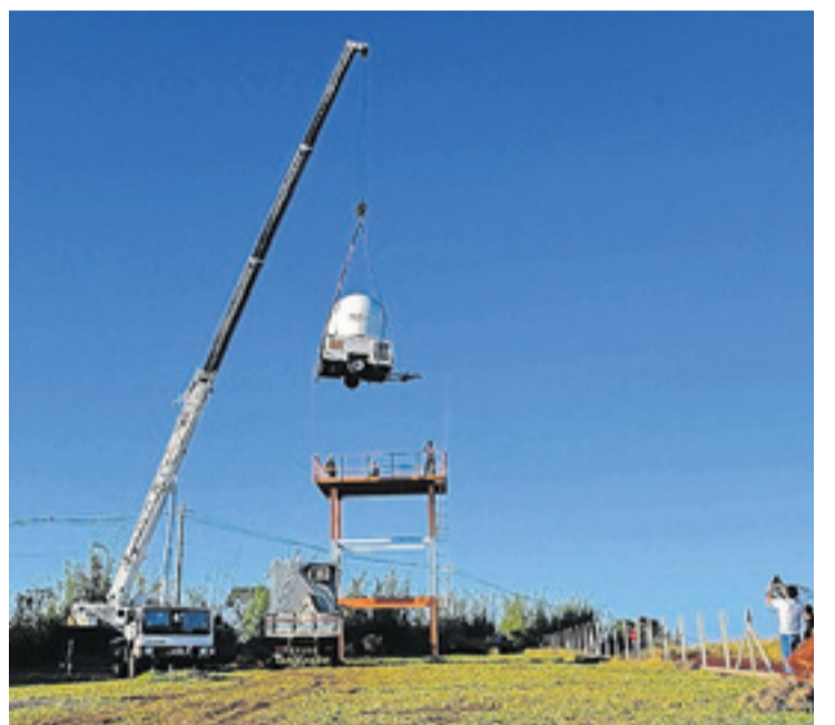
ÍÇAMENTO | Início da operação está previsto para 6 de outubro
